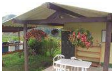
Figura 10. Área de descanso de los operarios.
